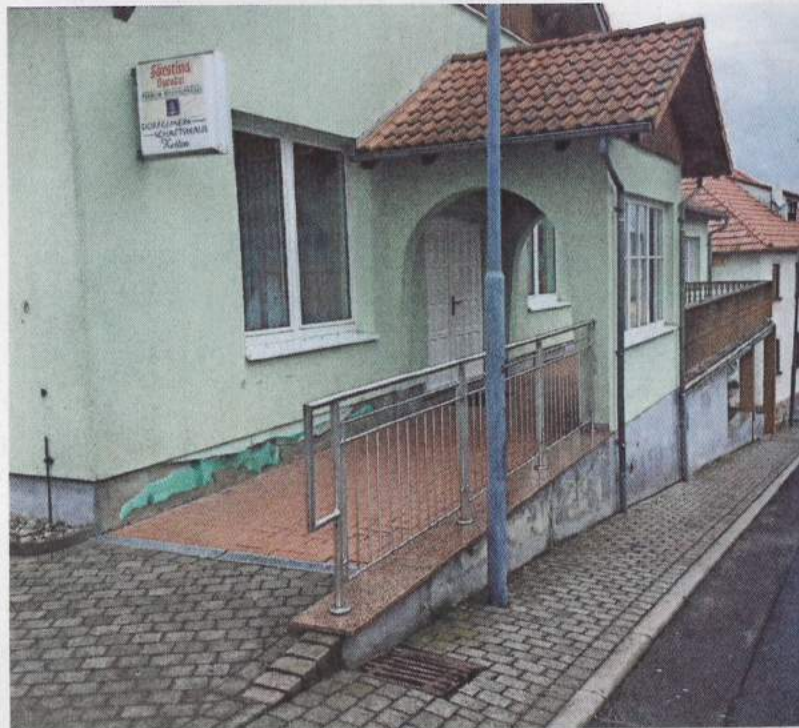
Sanierungsarbeiten nebst Umfeldgestaltung sind am Dorfgemeinschaftshaus in Ketten vorgesehen.
